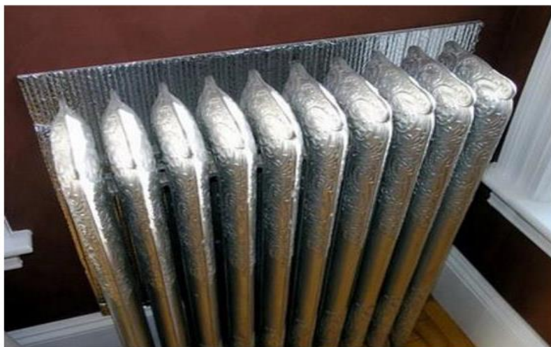
Пример установки теплоотражающего экрана
